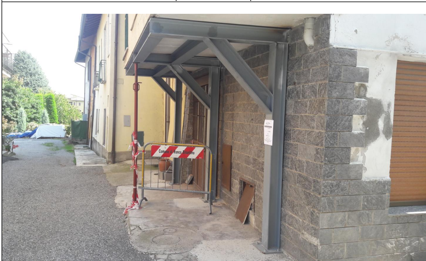
FOTO 1 : intervento in carpenteria metallica per rinforzo soletta a sbalzo
