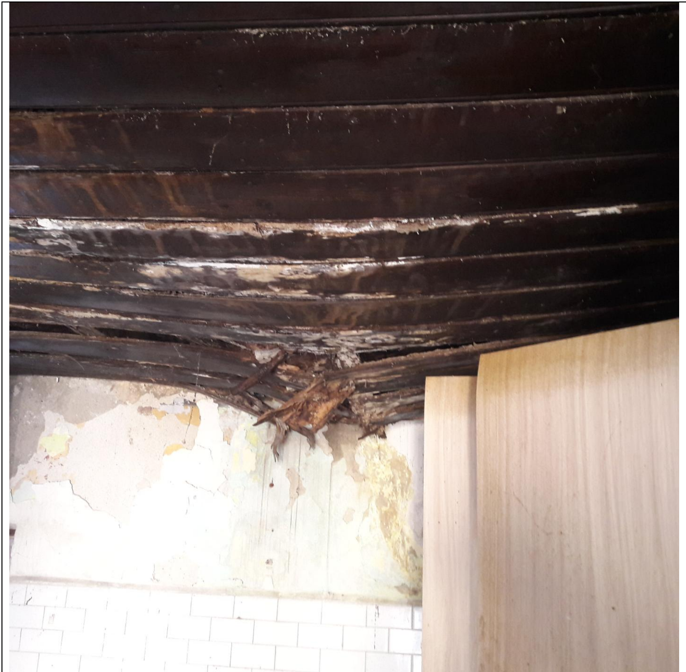
FOTO 8 : vista intradosso solaio sottotetto - marcescenza e infiltrazioni d'acqua
