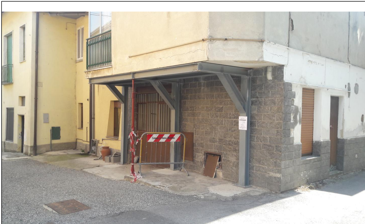
FOTO 1 : intervento in carpenteria metallica per rinforzo soletta a sbalzo
